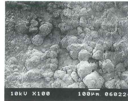
混和：緻密に粒状物質(ケイ酸カルシウム)が生成され、ひび割れが充填閉塞される
